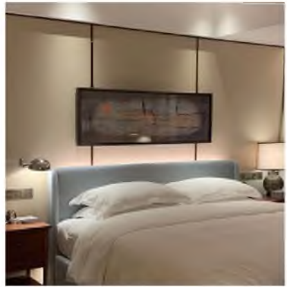
酒店房间：1.2 米实心大板 + 墙布 + 装饰线
